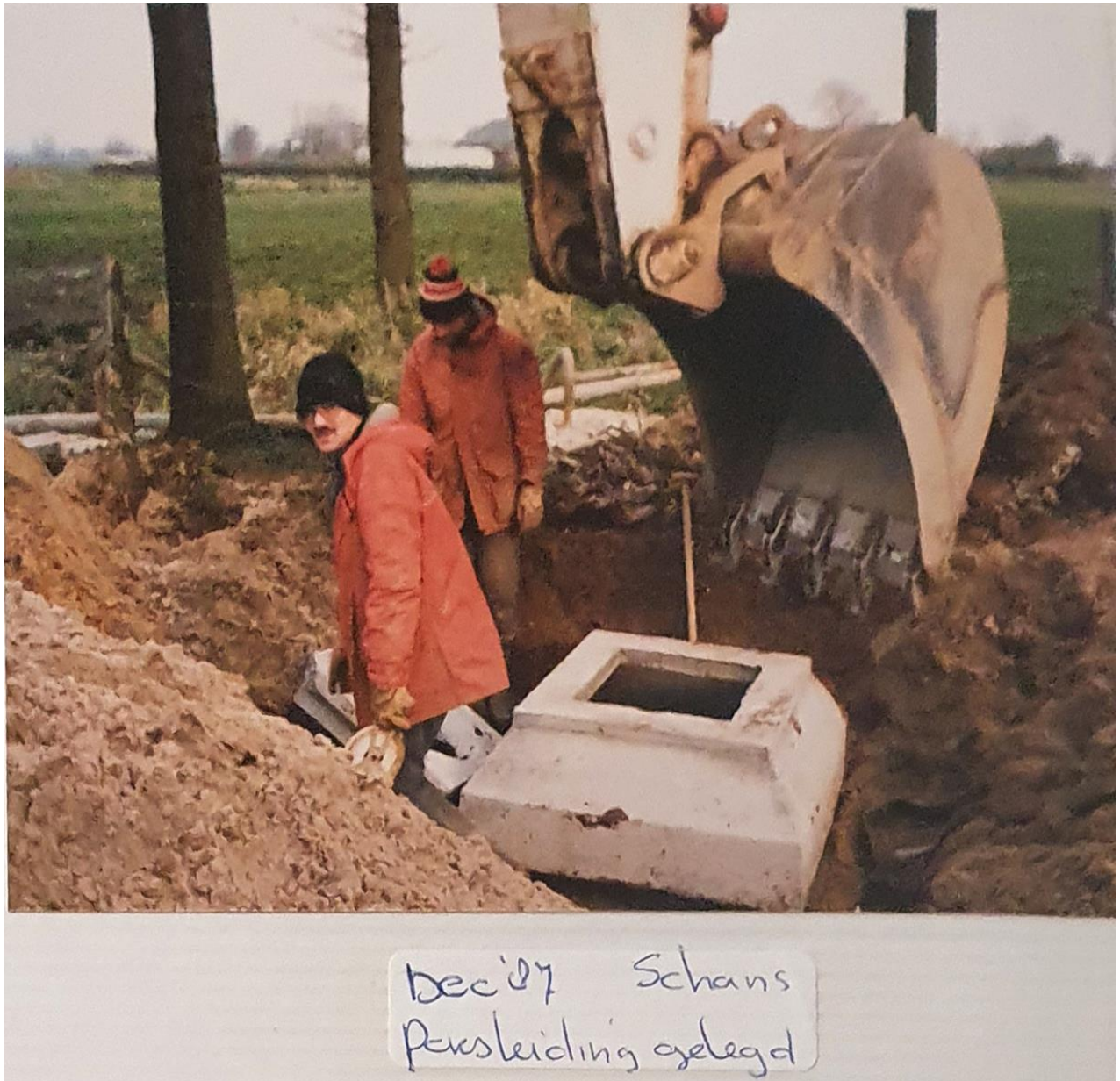
Afbeelding 49 Aanleg van de eerste persleiding in december 1987.
