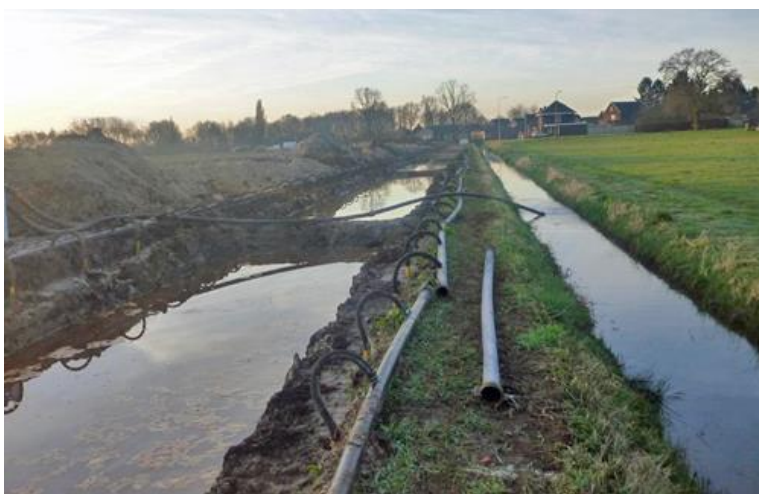
Afbeelding E De volgelopen sleuf van de aanleg van de persleiding en de huidige sloot (rechts). Kijkrichting zuid. Foto: Rapport RAAP 14 .
