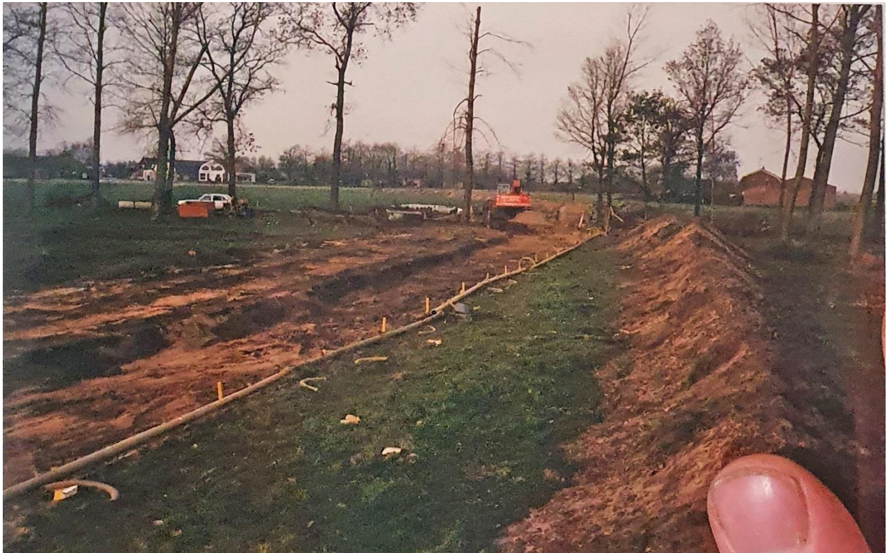
Afbeelding 50 Aanleg van de persleiding in december 1987.
